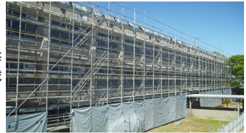
着々と改修が進む機械工学科棟
